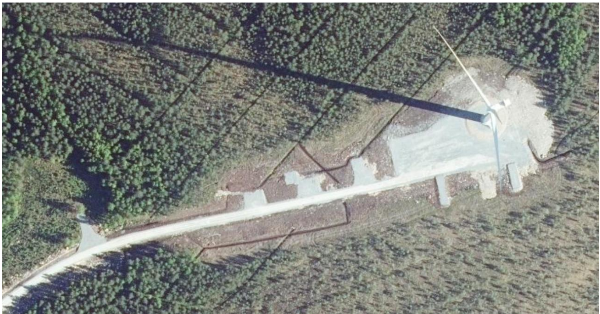
Kuva 16. Esimerkki juuri valmistuneen tuulivoimalan asennusalueesta. Ilmakuvan lähde: Maanmittauslaitos, avoimet aineistot 2022.
