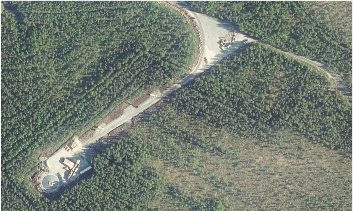
Kuva 14. Esimerkki tuulivoimalan rakennustyömaasta. Ilmakuvaan lähde: Maanmittauslaitos, avoimet aineistot 2022
