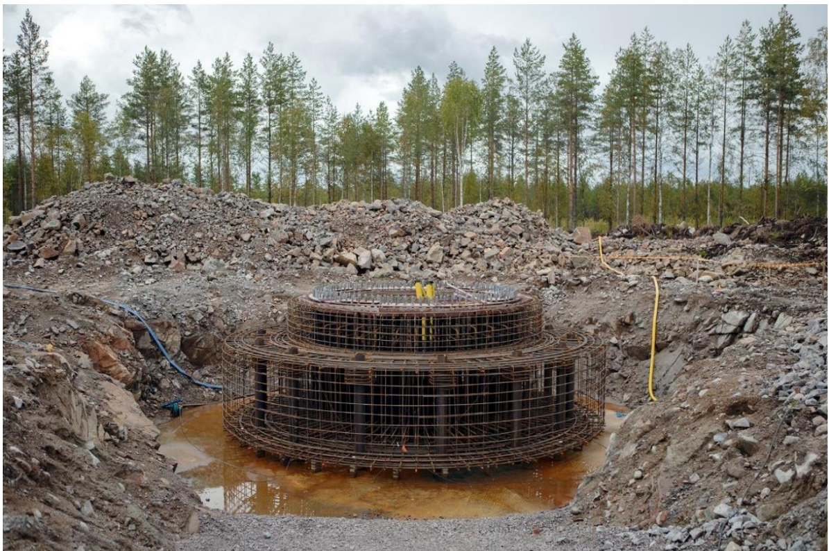
Kuva 10. Esimerkkikuva kallioankkuriperustuksesta (OX2 2022).
