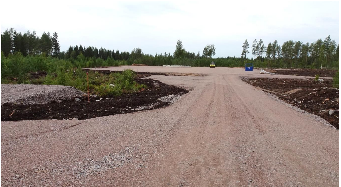
Kuva 15. Voimalan nostokentän rakennustyömaa. (Kuva J. Silvola, Ramboll)
