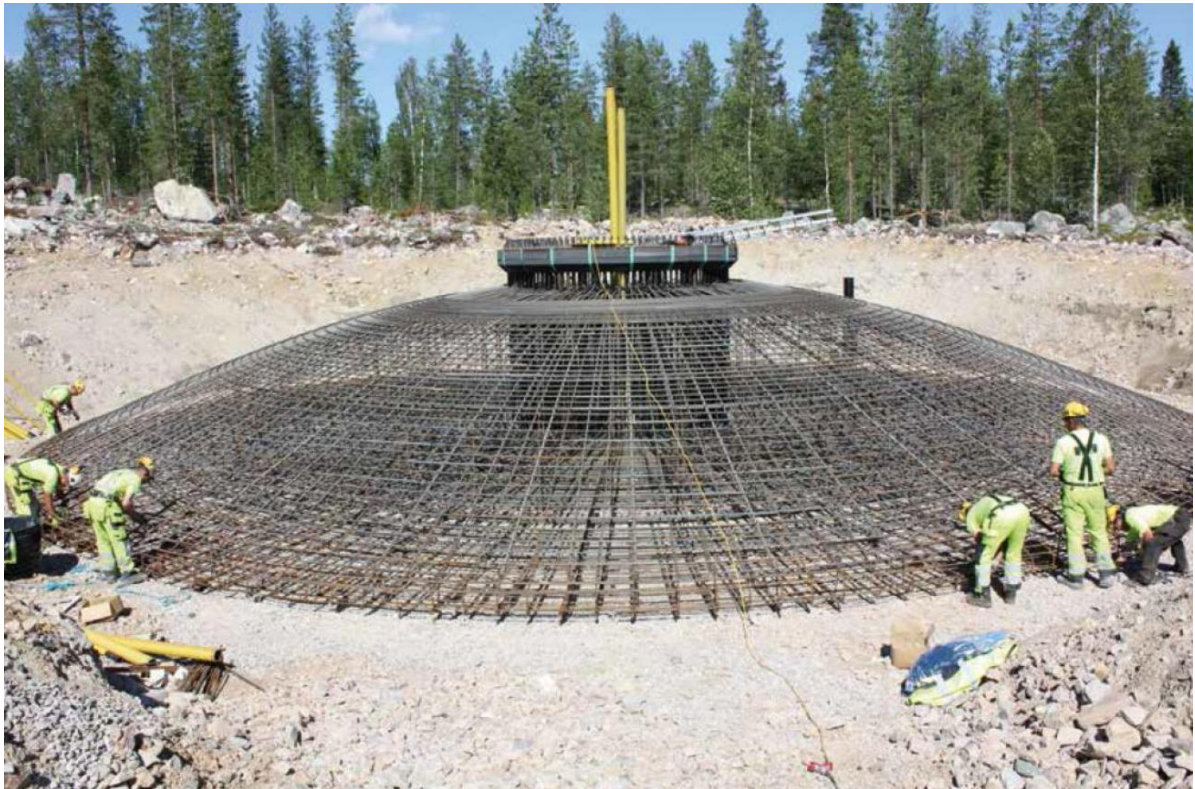
Kuva 9. Maavarainen teräsbetoniperustusraudoitettuna ennen betonivalua (OX2 2022).
