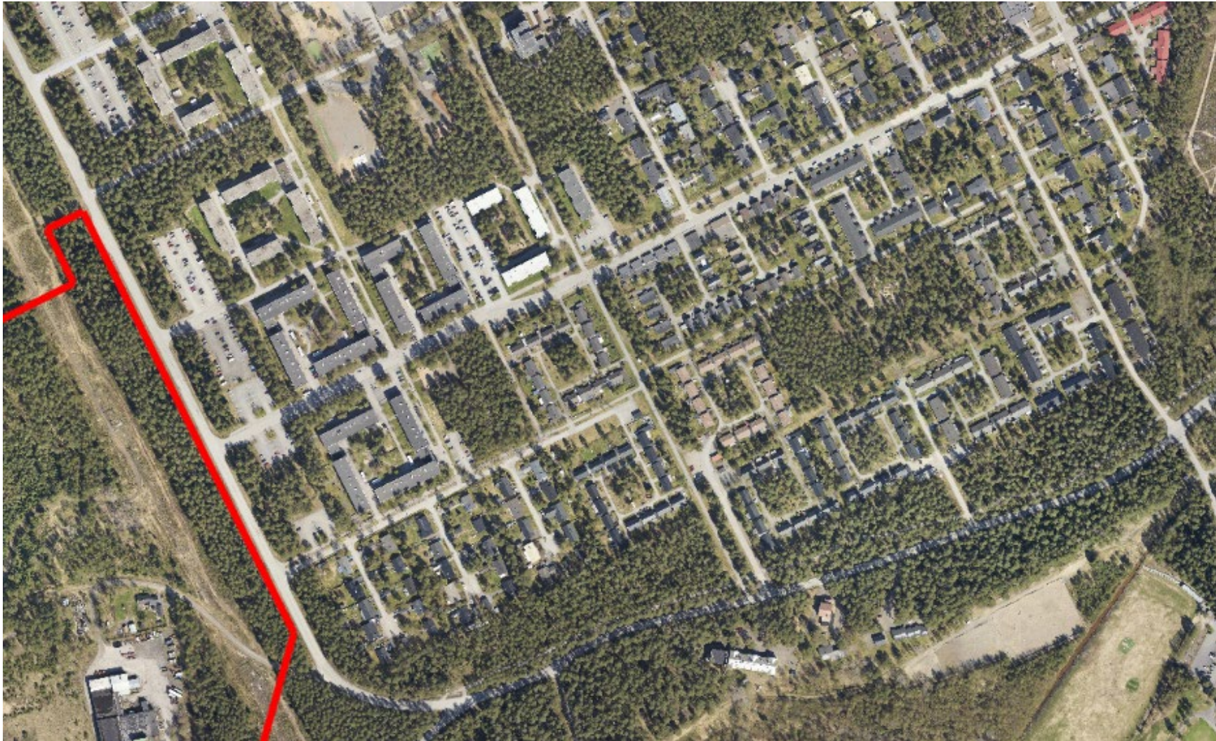
Suunnittelualueen länsipuolella on Koivuhaan lähiö, jonka 1970-luvulta peräisin oleva rakennuskanta koostuu kerros- ja pientaloista.
