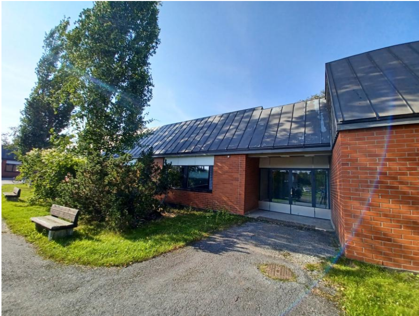
Rakennuksen toinen sisäänkäynti.
