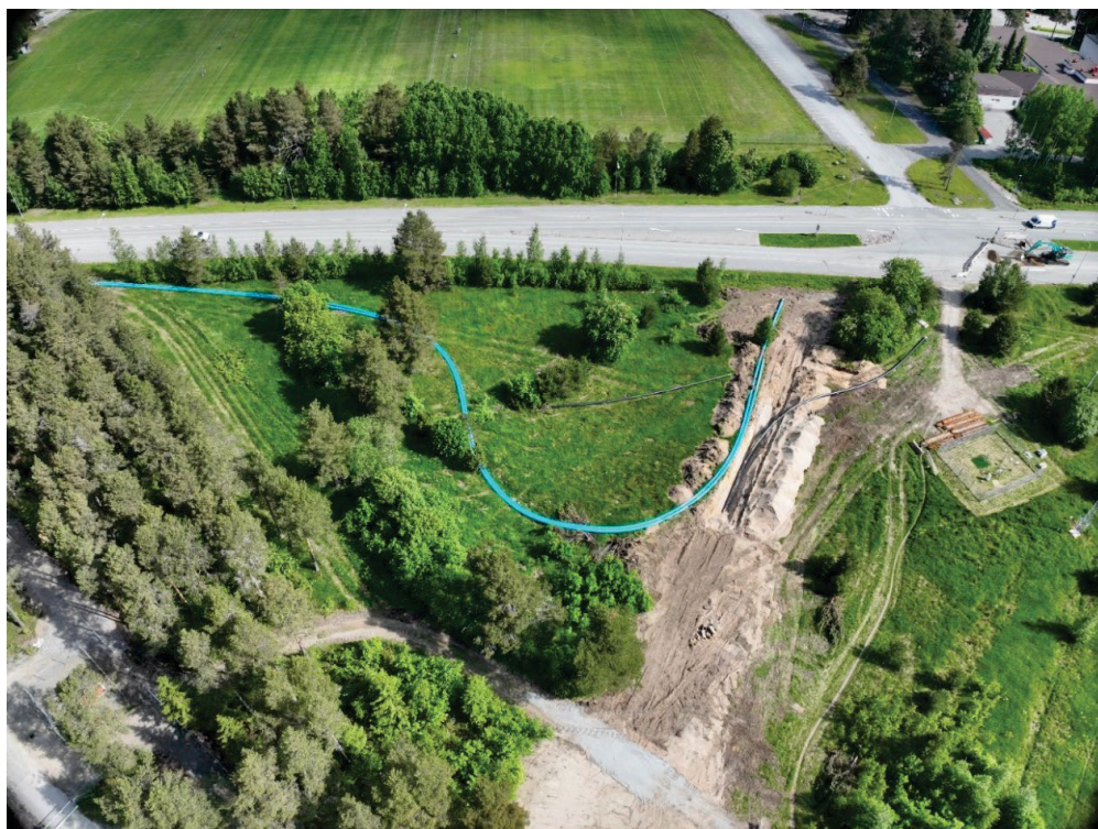
Bild. Sanering av vattenledningen vid Fabriksgatan.
