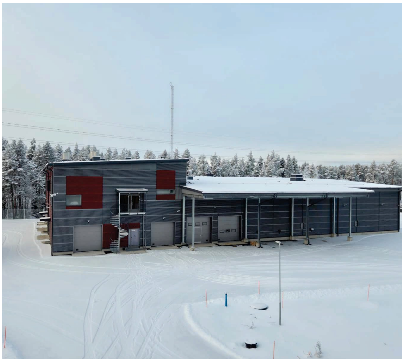
. Nya vattenreningsverket i Patamäki
