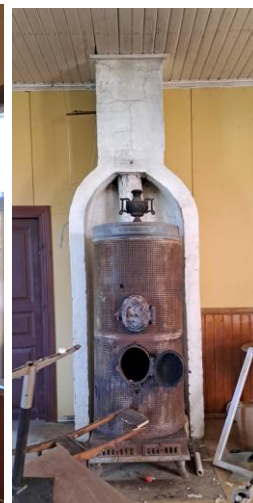
Valokuvia Marinkaisen työväentalon sisätiloista, 21.5.2026. Valokuvissa näkyy romahtanut kattorakenne talon pohjoisosassa.
