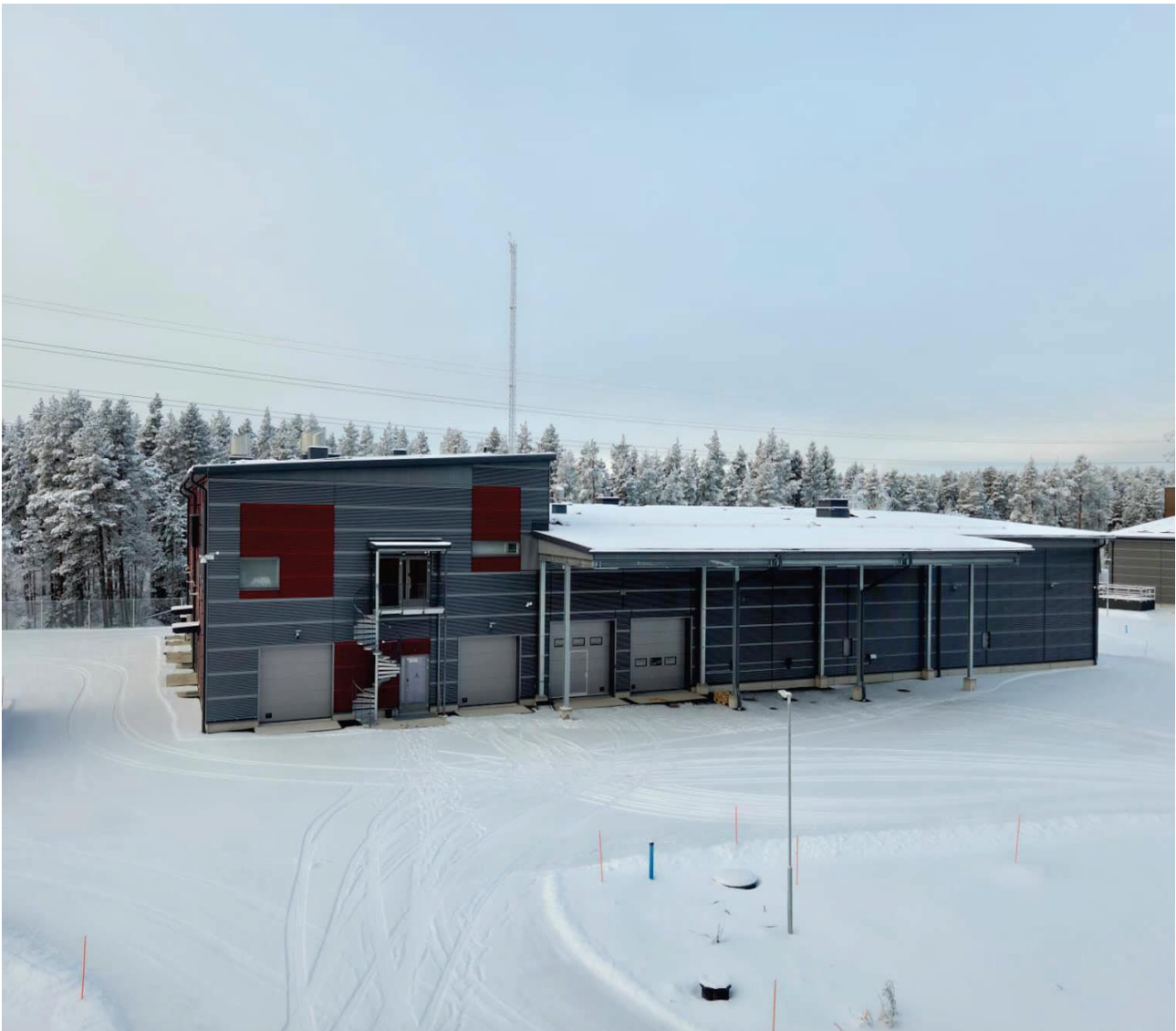
Kuva. Patamäen uusi vedenkäsittelylaitos
