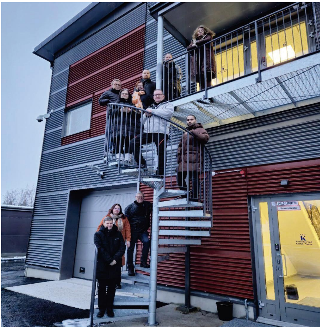
Kuva. Johtokunta tutustumassa Patamäen uuteen vedenkäsittelylaitokseen.
