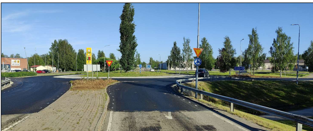
Kuva 17. Valtatien 28 ja kantatien 63 liittymä Sievissä, näkymä Kannuksen suunnalta.
