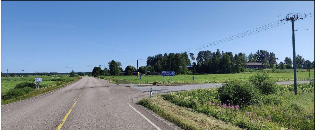
Kuva 19. Seututien 775 ja paikallistien 18097 liittymä Sykäräisessä, näkymä Toholammin suunnalta.
