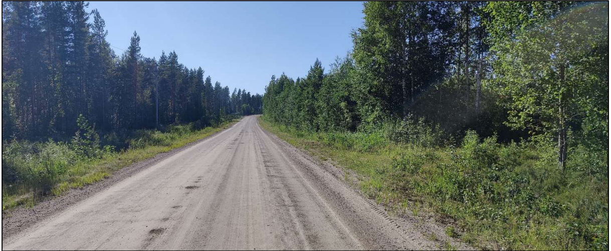
Kuva 21. Paikallistien 18097 ja toisen Tuohimaan osa-alueelle johtavan tien liittymä.
