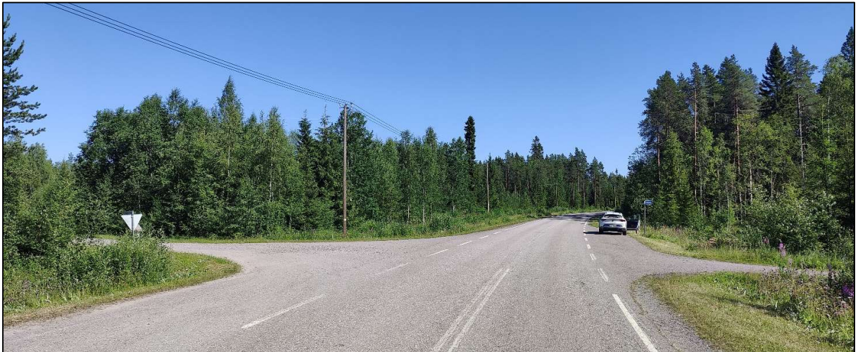
Kuva 28. Yhdystien 7511 ja Petäjämaantienliittymä Pajuojalla, näkymä Köyhäjoen suunnalta.
