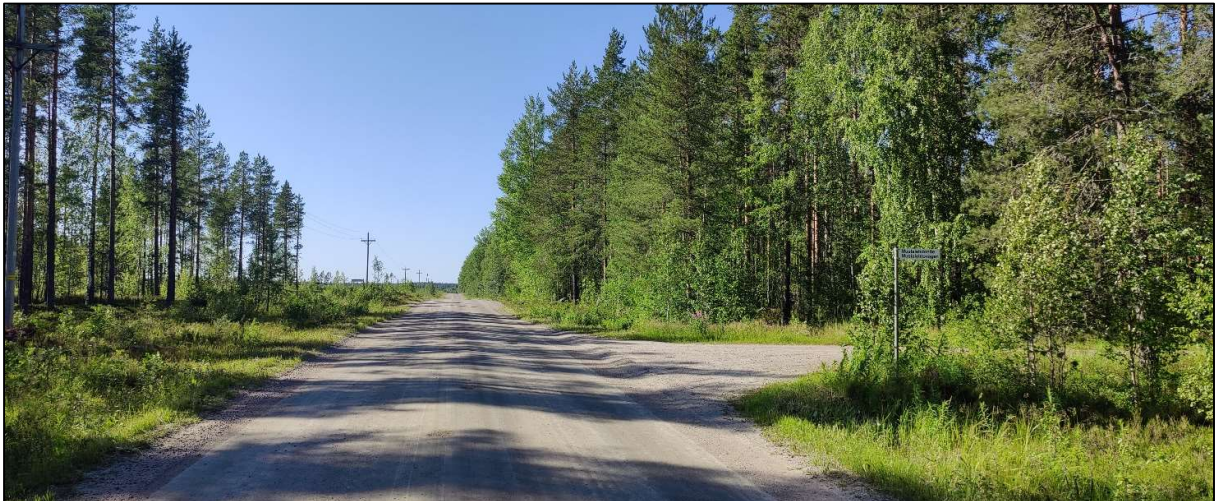
Kuva 22. Paikallistien 18097 ja kolmannen Tuohimaan osa-alueelle johtavan tien liittymä.
