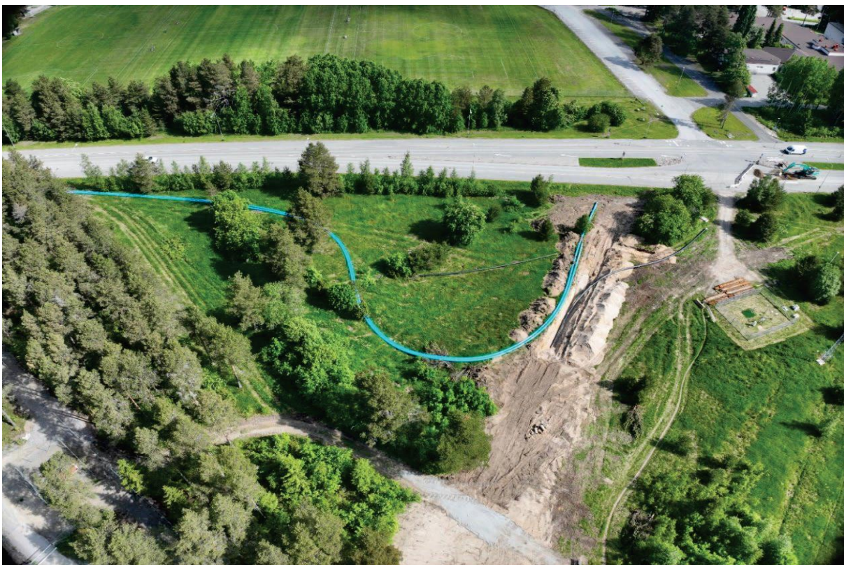
Kuva. Tehtaankadun vesijohdon saneeraus.
