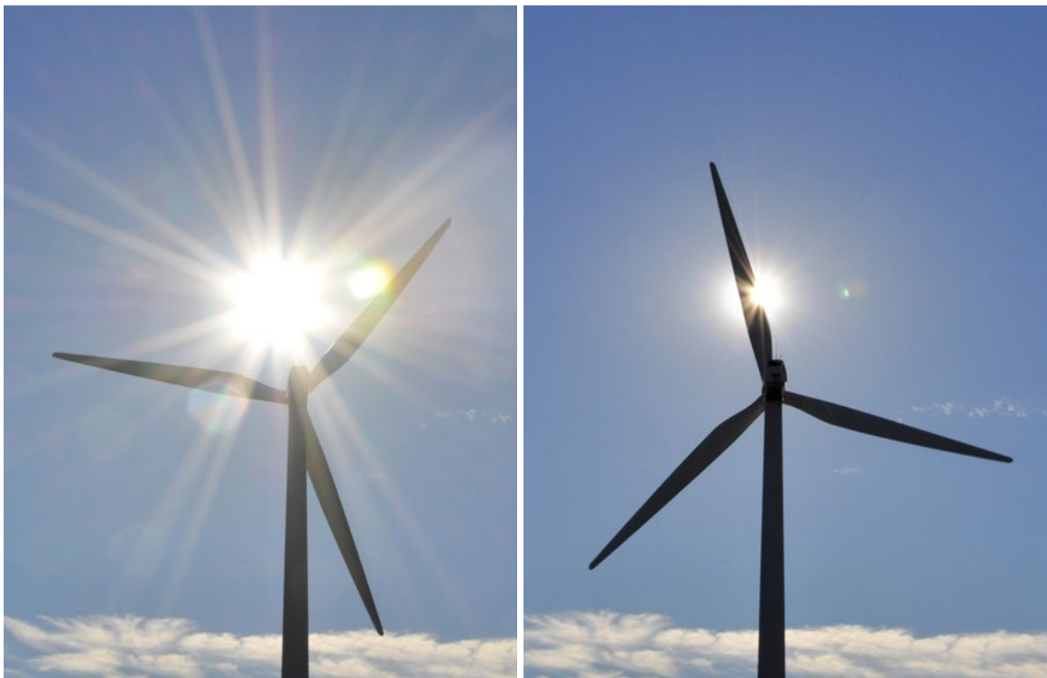
Kuvapari 54. Tuulivoimaloiden lavat aiheuttavat pyöriessään vilkkumista ja varjon välkkymistä aurinkoisella säällä. (© FCG)
