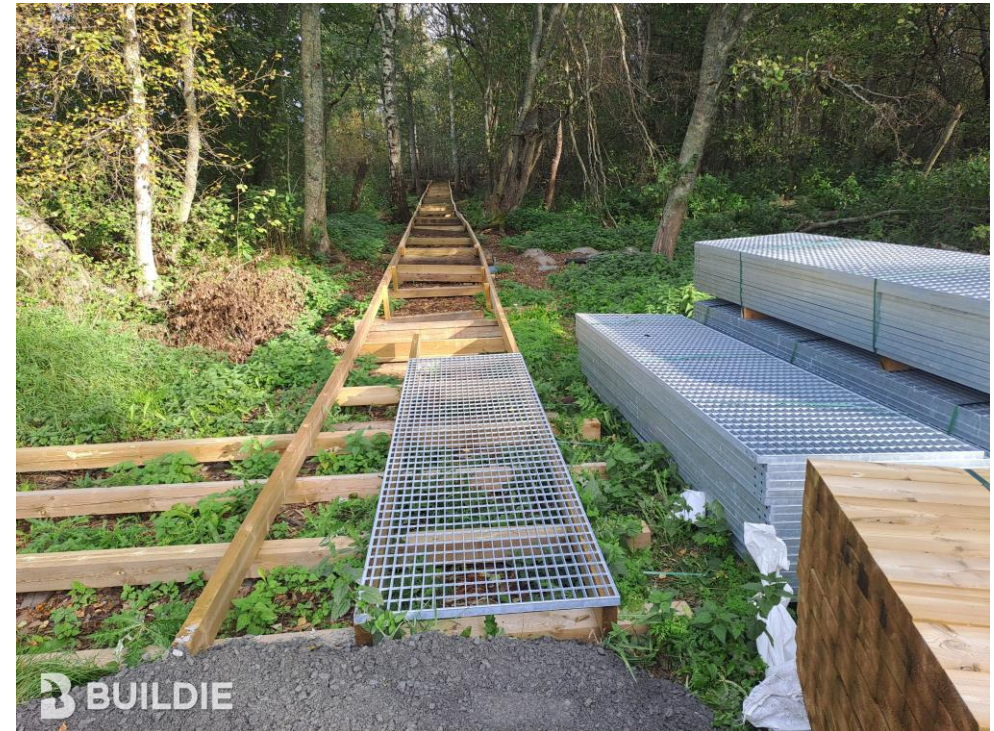
Kuva: Isokarin esteettömän luontopolun rakentaminen
