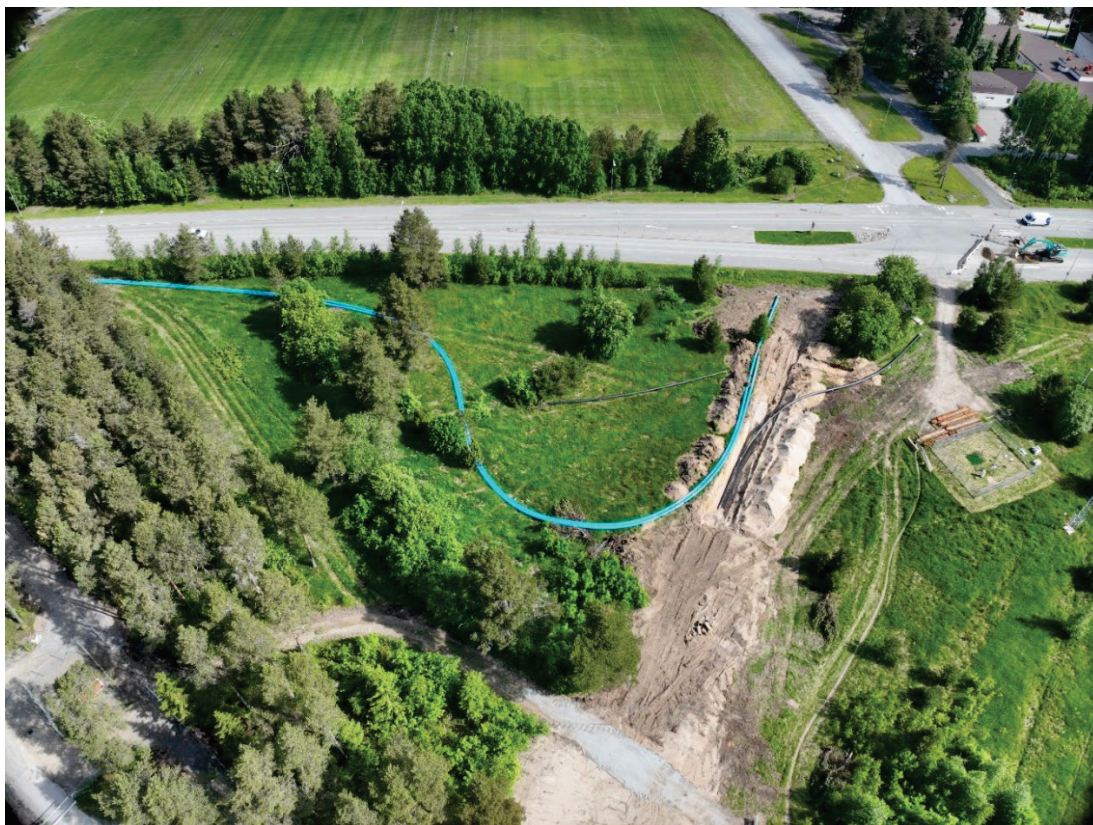
Kuva. Tehtaankadun vesijohdon saneeraus.
