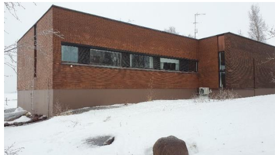
Havsstugan sett från söder. Ovanför trappans vertikala fönster har man använt kopparplåt på fasaden.
