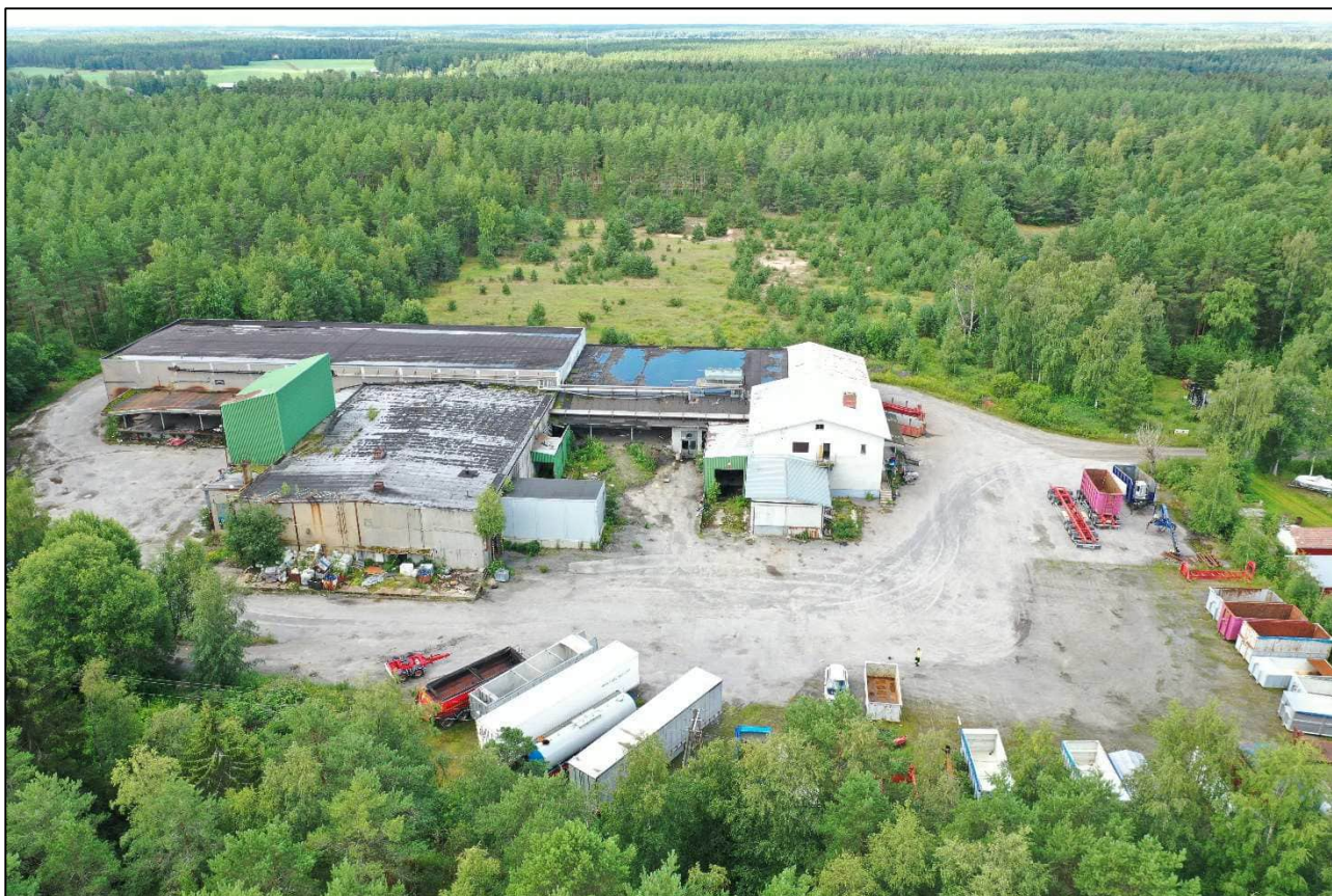
Kuva 4. Näkymää entiselle Oy Jäkäla Ab:n tuotantolaitokselle sekä entiselle turkistarhan alueelle idän suunnalta. Kuva on otettu heinäkuussa 2023.
