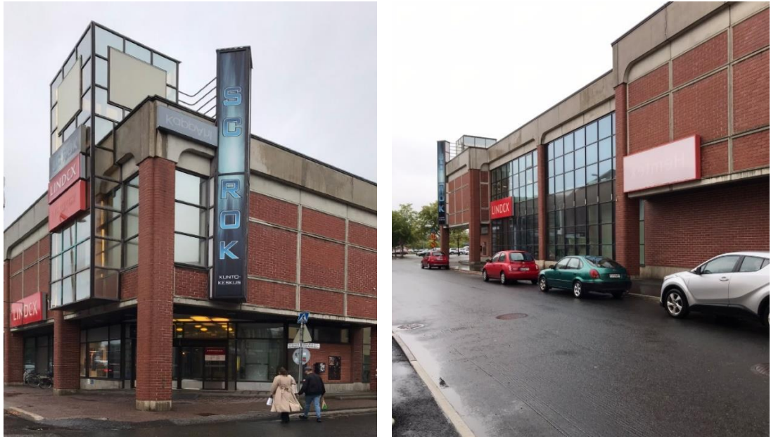
Figurer 6. Till vänster: Huvudingången till f.d. Anttila finns i hörnet av Fabriksgatan och Östra Kyrkogatan. Till höger en vy i riktning med Östra Kyrkogatan mot Fabriksgatan (september 2023).
