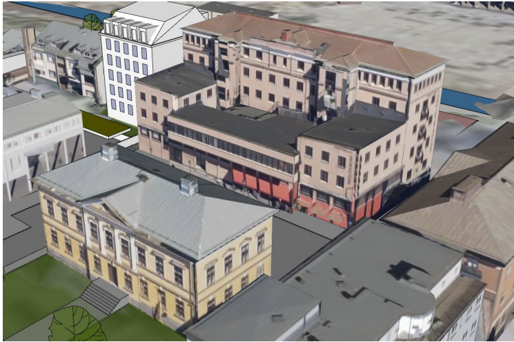
Vaihtoehtotarkasteluja Seurahuoneen kiinteistöstä.
