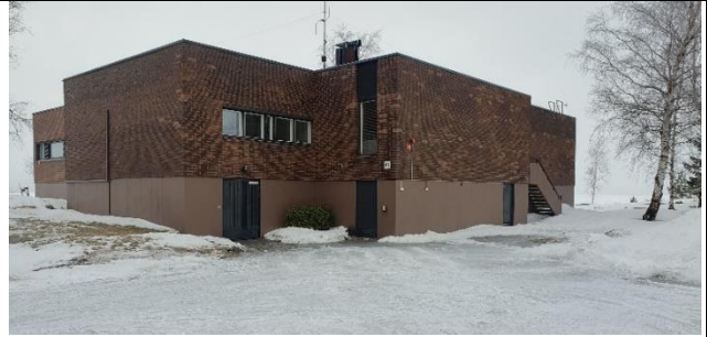
Vierasmaja kuvattuna kaakosta. Rakennuksen pääsisäänkäynti sijaitsee ensimmäisessä kerroksessa.
