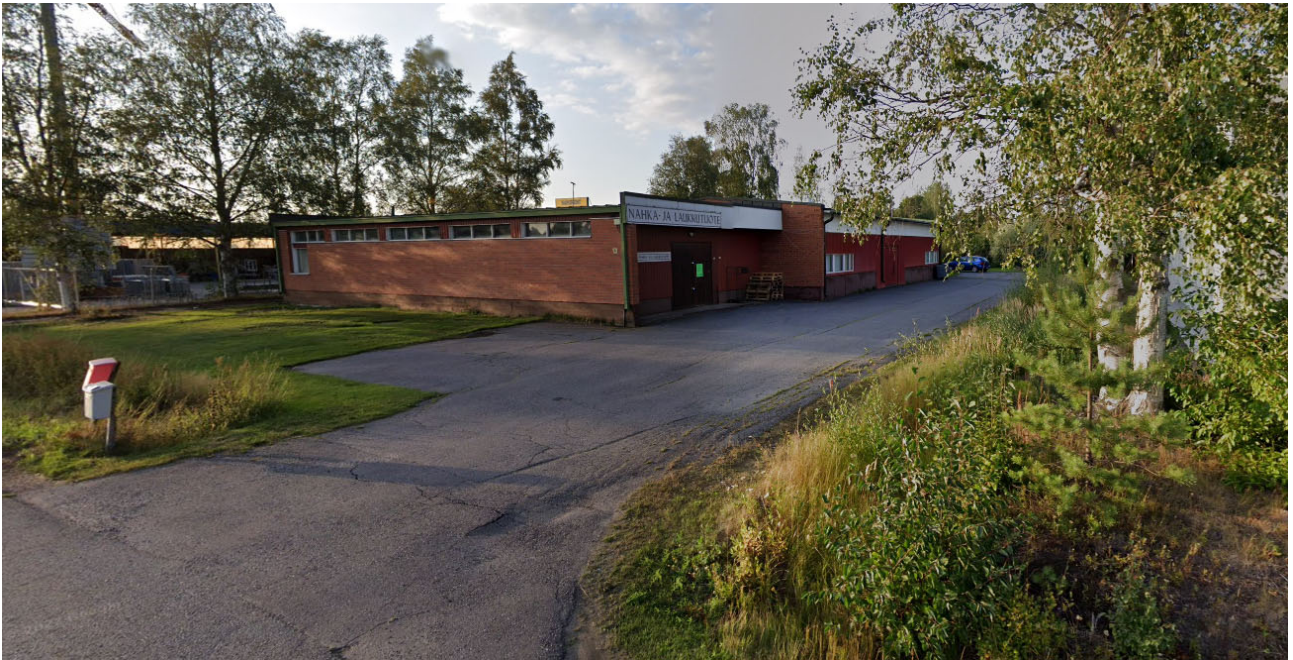
Foto 4 Patamäkvägen 8. Delen längre bort har byggts före 1973 och främre delen före 1976.
