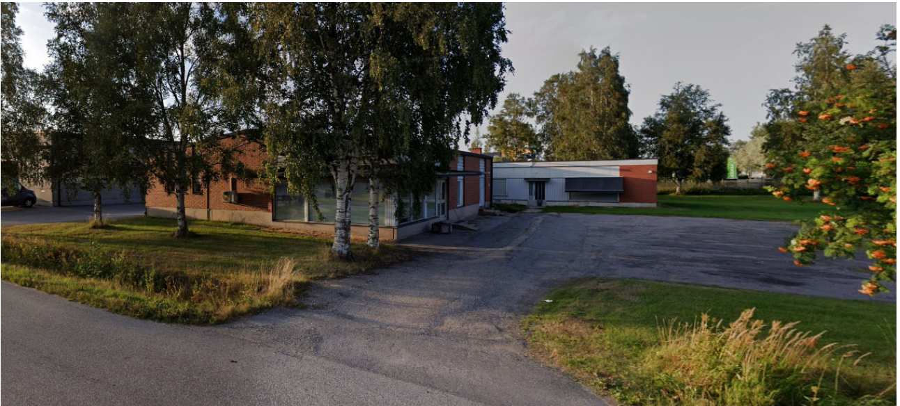
Foto 2 Patamäkvägen 2. Byggnadsdelen bakom har byggts före 1973 och den framför före 1986.
