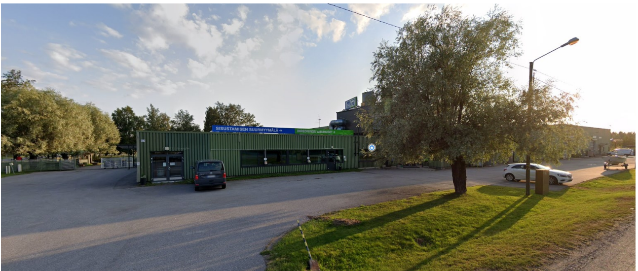
Kuva 5a, Yrittäjäntie 5. Rakennettu ennen vuotta 1976. Joiltakin osin myöhemmin laajennettu. Kuva vuodelta 2019.
