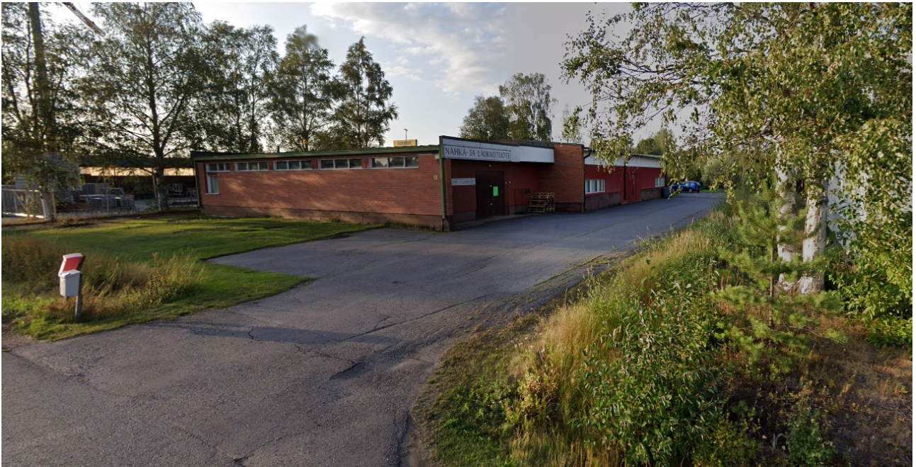
Kuva 4 Patamäentie 8. Taempi osa rakentunut ennen vuotta 1973 ja edessä oleva osa ennen vuotta 1976.
