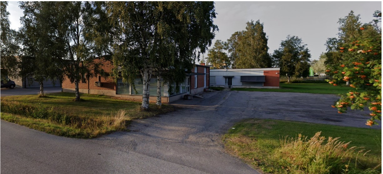
Kuva 2 Patamäentie 2. Takana oleva rakennusosa rakentunut ennen vuotta 1973 ja edessä oleva ennen vuotta 1986.
