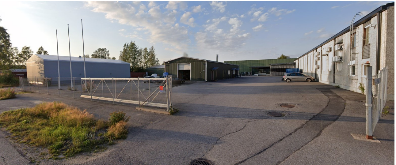
Kuva 3 Patamäentie 4a. Rakentunut ennen vuotta 1973.
