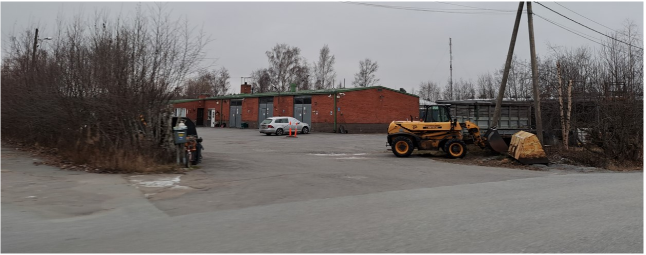
Kuva 6, Yrittäjätie 9. Rakennettu ennen vuotta 1976.
