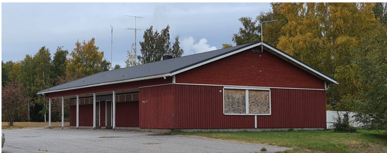
Figur 10. Ekonomibygnad på skolgården.
