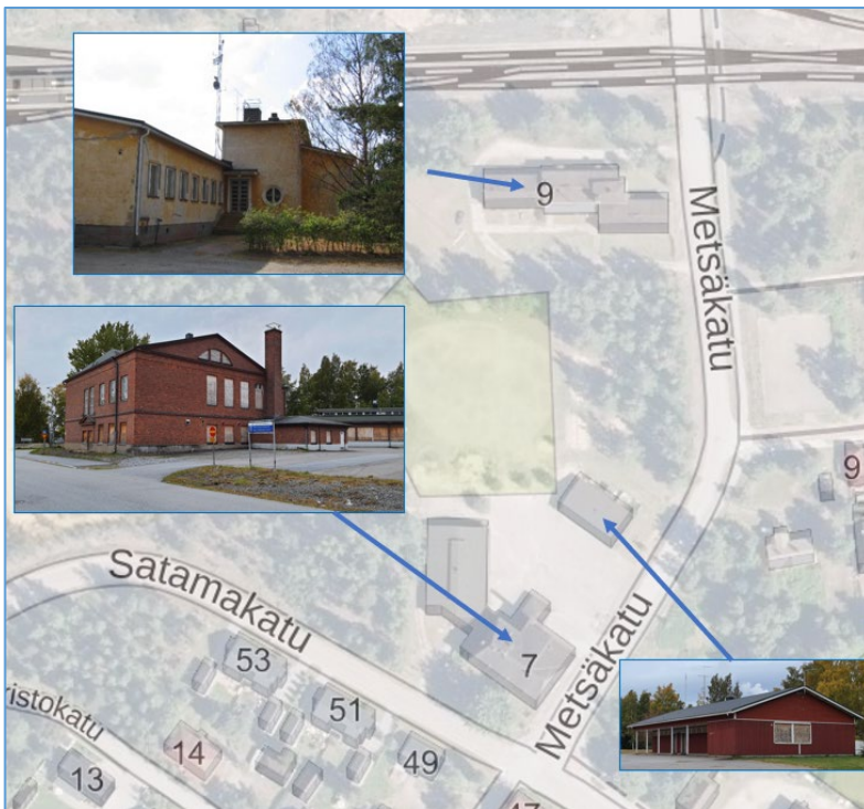
Kuva 33. Metsäkadun varren rakennukset.
