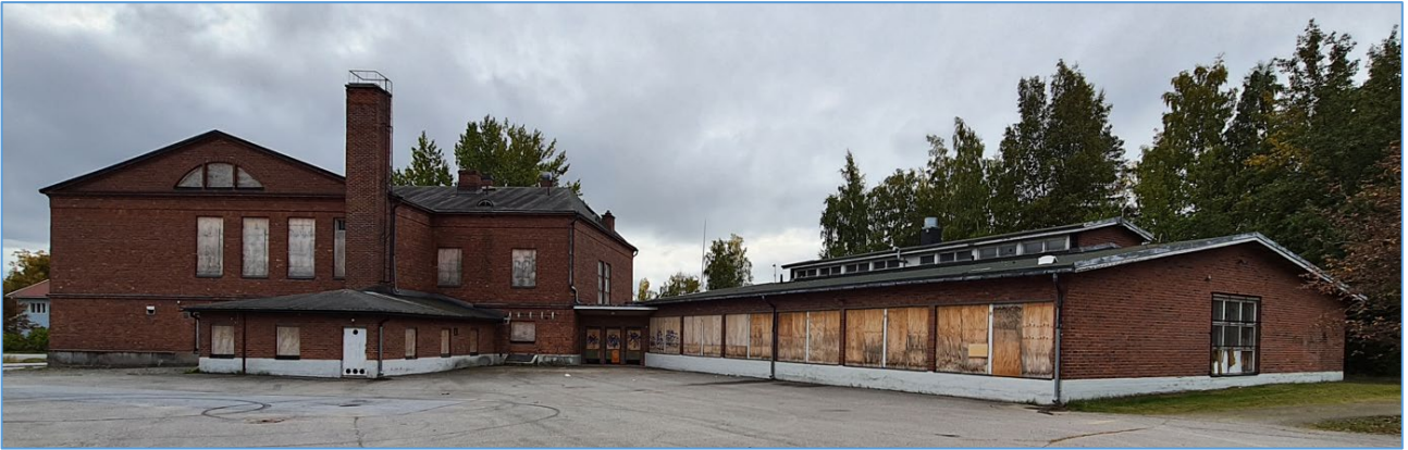
Kuva 9. Ykspihlajan vanha koulurakennus.
