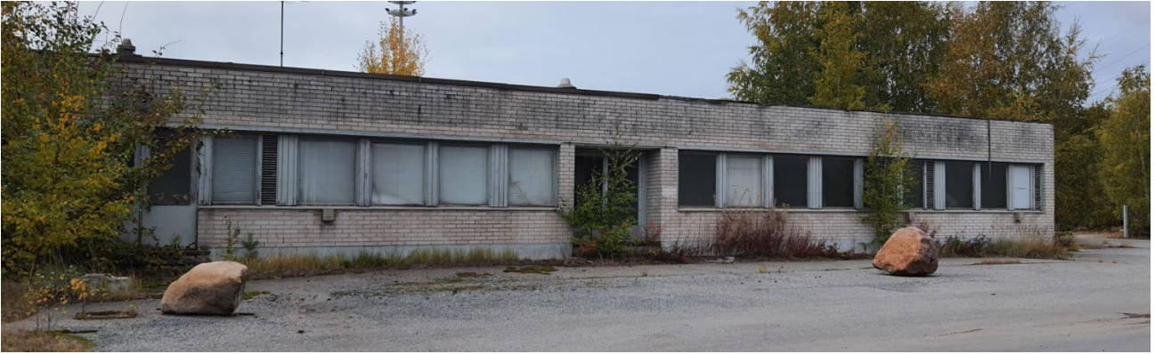
Kuva 12. Junaradan varren teollisuusrakennuksen julkisivu Metsäkadun suuntaan.
