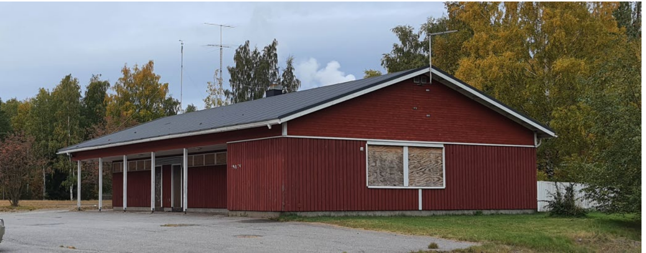
Kuva 10. Koulurakennuksen pihassa oleva talousrakennus.
