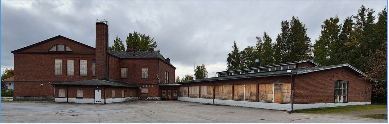
Kuva 9. Ykspihlajan vanha koulurakennus.
